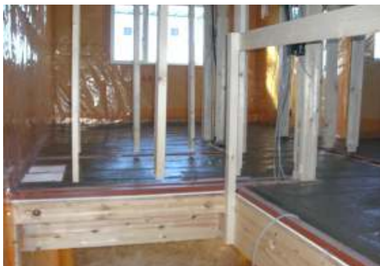
蓄熱用モルタル(30mm)施工
