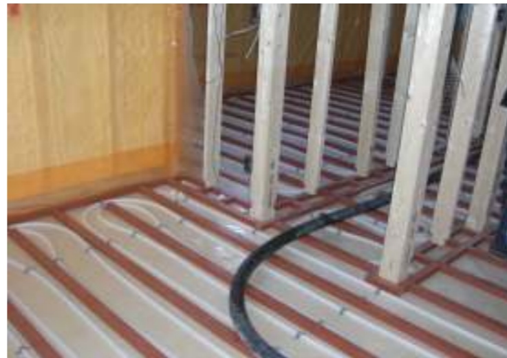
樹脂の部材で壁柱をすべて保護
