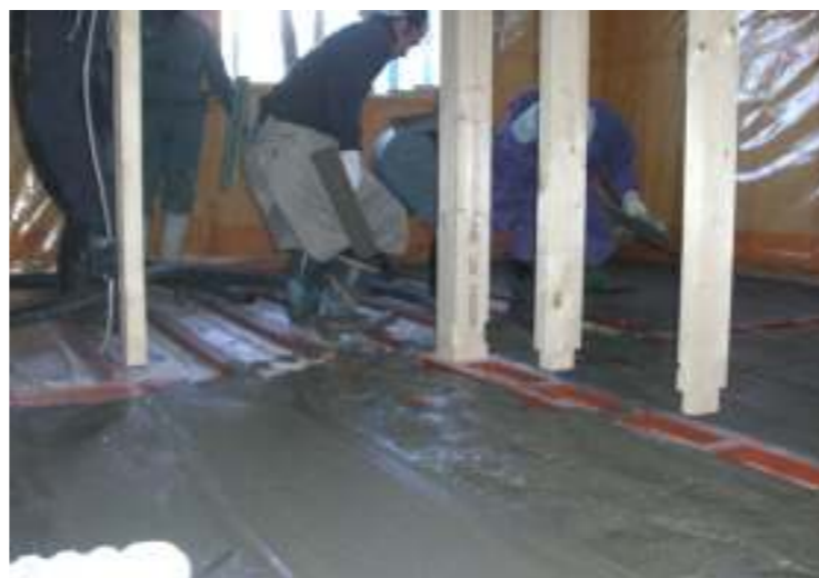
蓄熱用モルタル施工
